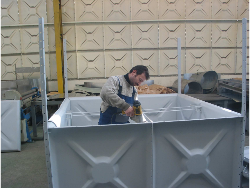
ŞEKİL 7 1.Sıra modüllerin montajı
