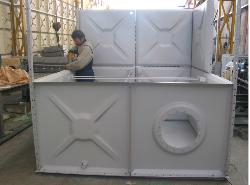
ŞEKİL 8 2.Sıra modüllerin montajı
